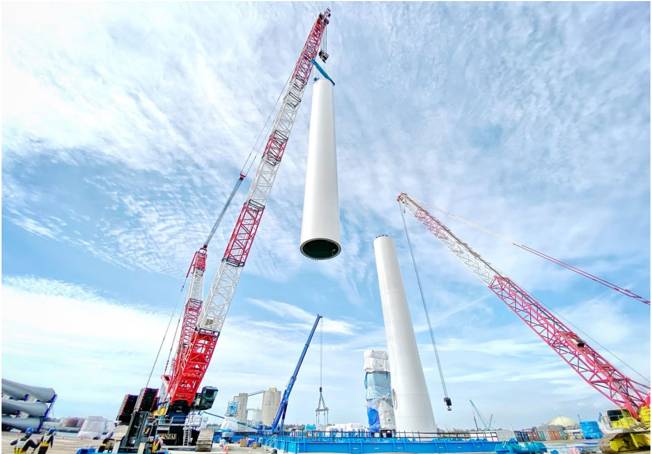
(台湾・台中港 洋上風力発電機組立作業)
