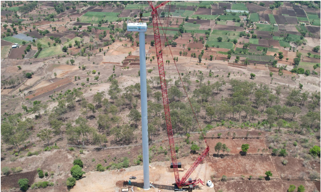
(インド・カルナータカ州の Senvion India 社 風力発電所建設)
