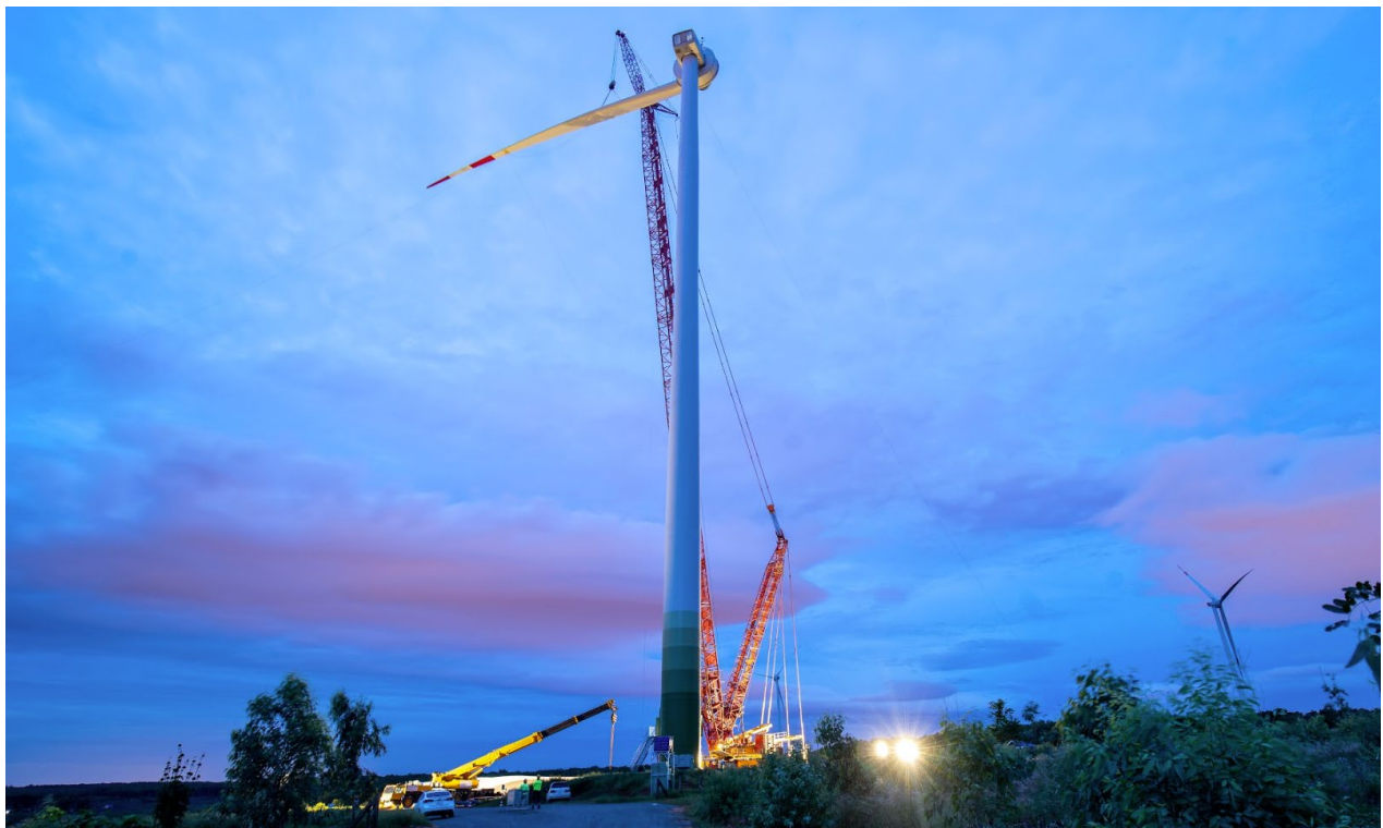
(ベトナム・ビントゥアン省 陸上風力発電所建設)
